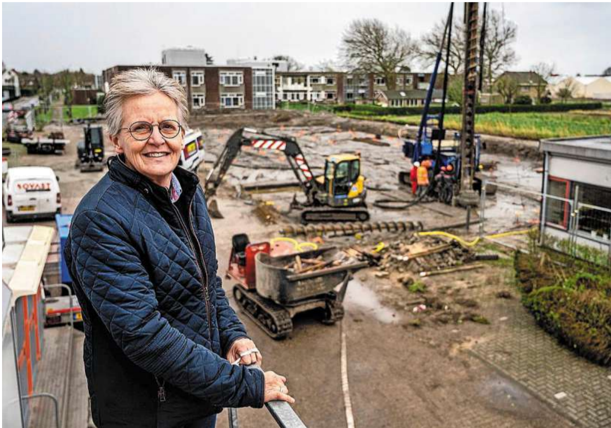
Locatiemanager Fransca Grimbergen bij de bouwplaats.
